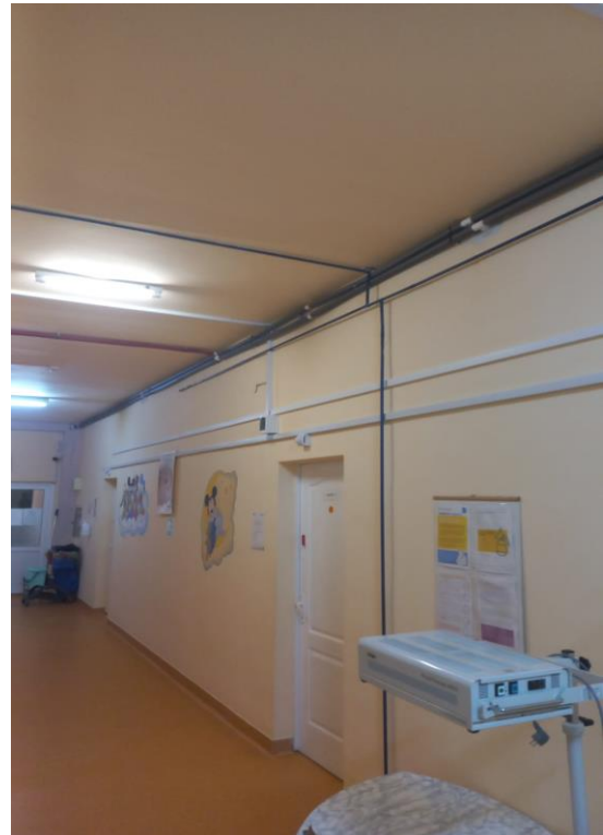
Inlocuire retea apa calda /apa rece sectie Obstretica Ginecologie
